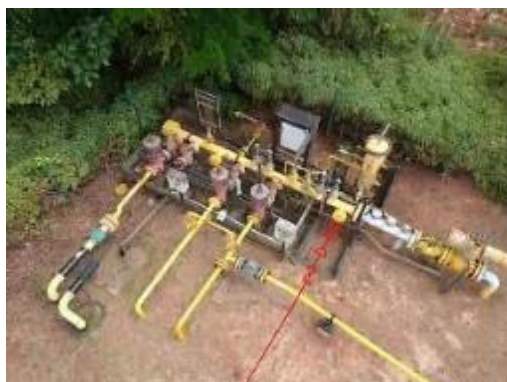
Figure 11: Tie-in nouveau pipe 6'' Gaz M' BOUKOU sur Manifold Gaz OZANGUE Station. (source POGG;2021).
