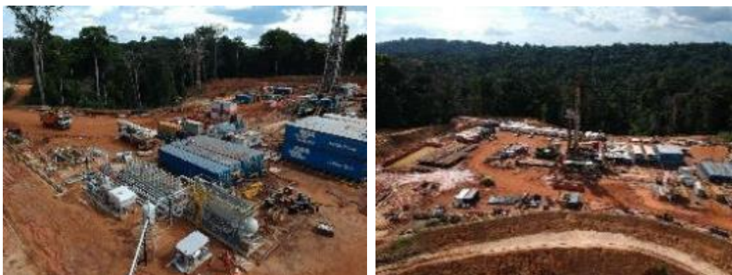
Photo 4: Exemple de réalisation (Cluster / Diga5).
