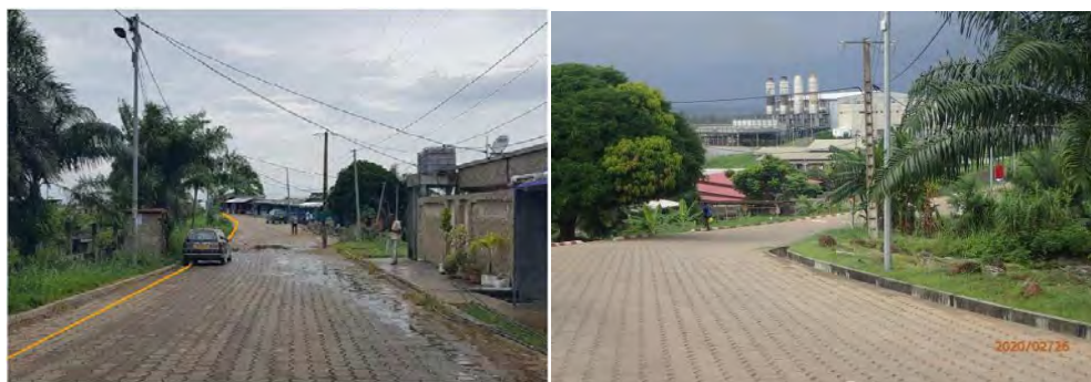
Photo 2 : vue de la voie en pavés, zone 1
