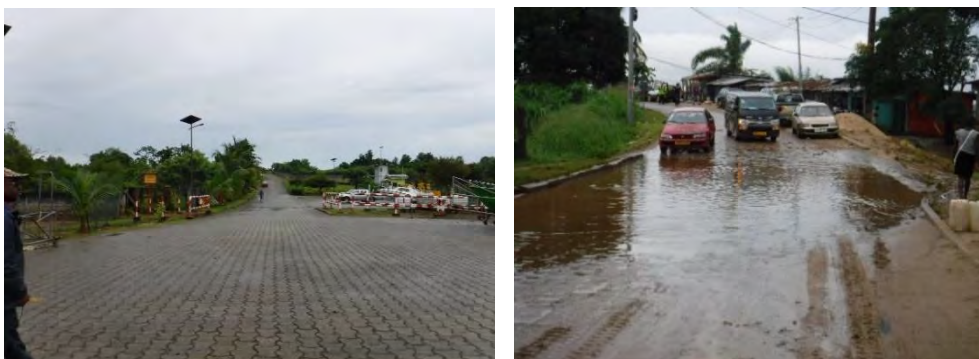
Photo 19 : Vues partielles du tronçon Pérenco - CES Alénakiri (zone 1), TERE, Avril 2021.
