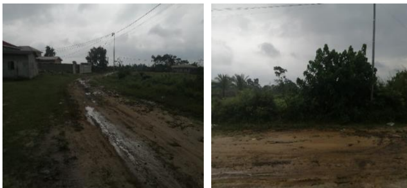
Photo 2: Vue de l'état de la voie d'accès au site du pylône.
