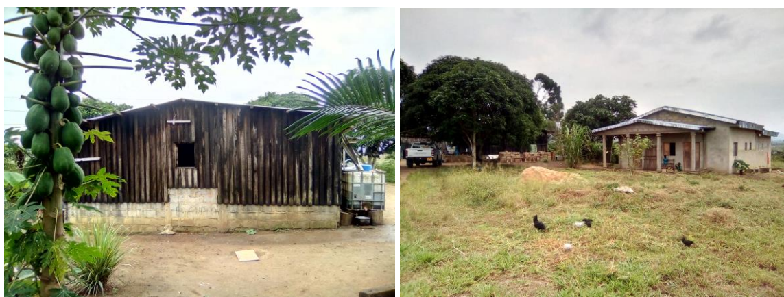
Planche de photos 2 : Vue de l'habitat présent sur le site
