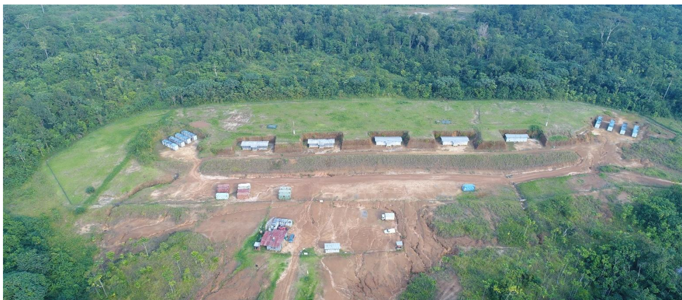
FIGURE 2: VUE AERIENNE DE L'ETAT ACTUEL DU SITE.
