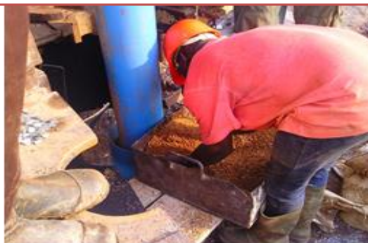
Photo 3: gravillonnage de l'espace annulaire.
