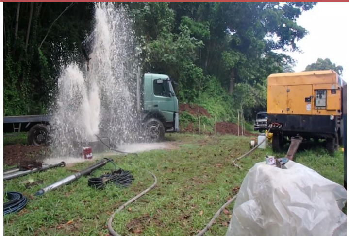
Photo 4 : Développement du forage à l'air lift.
