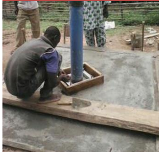
Photo 6: réalisation d'une margelle de forage hydraulique.
