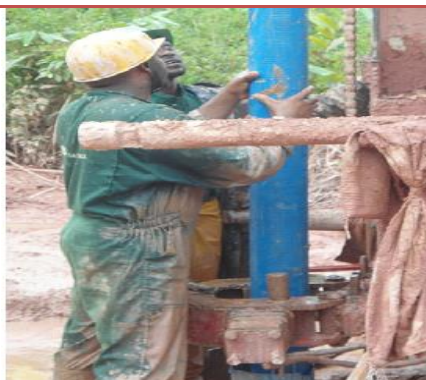
Photo 2: Tubage du forage en PVC pleins et crépinés.
