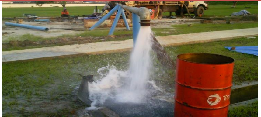
Photo 5 : Essais de Pompage après la foration.
